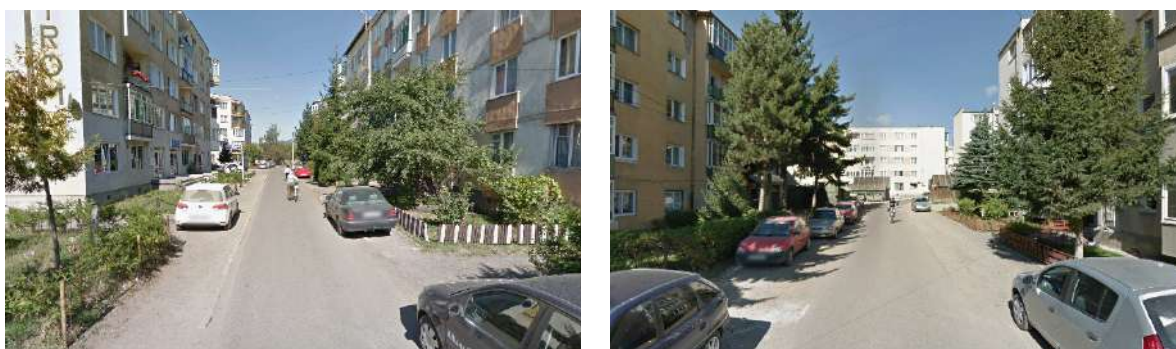
Figură 2-62 Starea carosabilului și a suprafeței pietonale pe strada Cartierul Florilor
