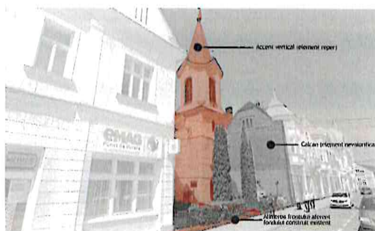
Figura 20 – Frontul construit de pe Strada Carpați și Biserica Reformată
