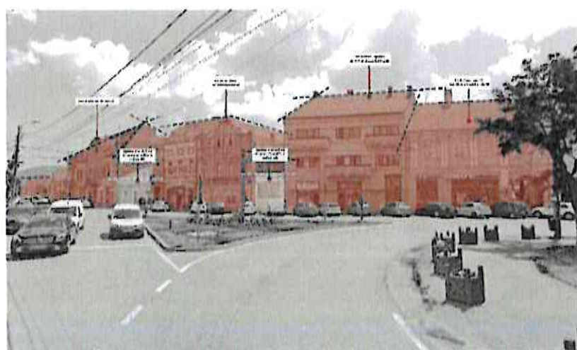
Figura 22 – Frontul construit de la intersecția Străzii Piața Libertății cu Strada Strada Mărtan Áron
